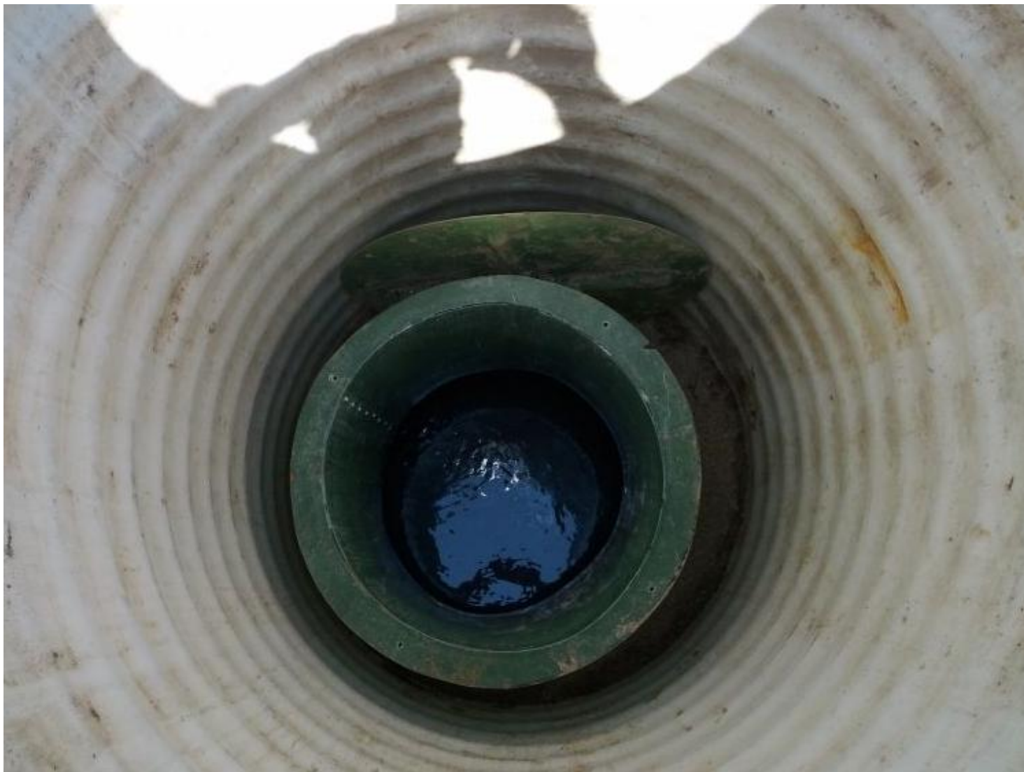
Fig. 13. Interiorul puțului de control al apelor de infiltrații.
